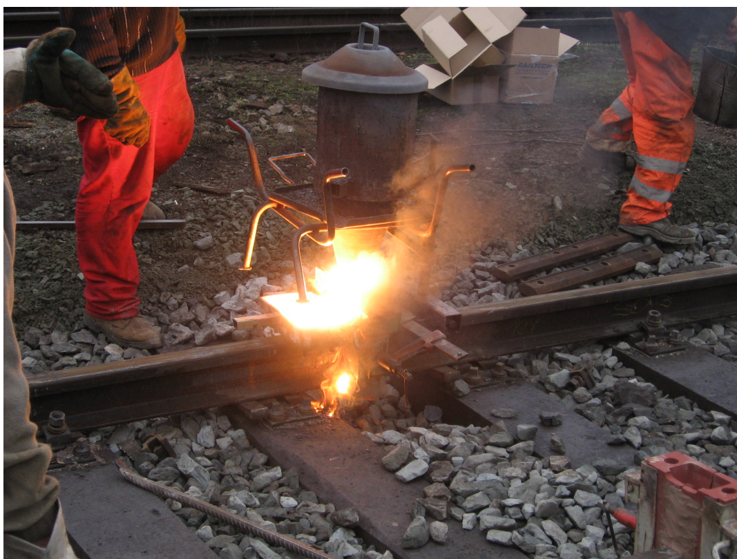
FIGURE 16.1 – Soudage de rails de chemin de fer par aluminothermie. Par PetrS. – CC BY-SA 3.0, https://commons.wikimedia.org/w/index.php?curid=29167522
